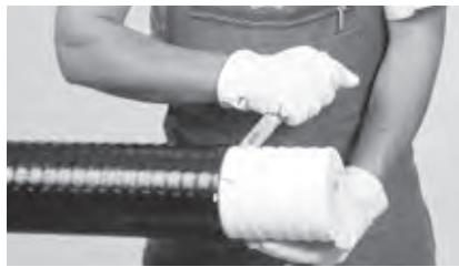
**5** Снять изоляцию на длину (X, Y, Z).
