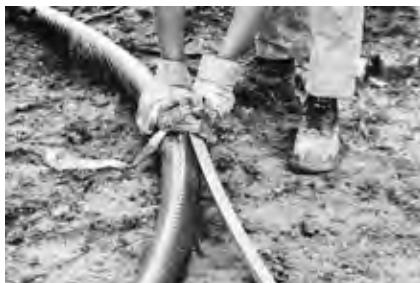
Закрепить трубопровод CALPEX на одном конце поворотной линейки при помощи натяжного ремня.
