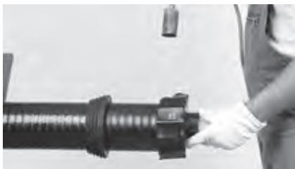
**7** Одеть термоусадочную муфту и аккуратно нагреть её с помощью газовой горелки, согласно руководства по монтажу Raychem DHEC.
