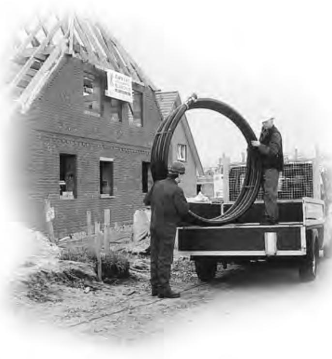
Опускание бухт на землю следует производить с особой осторожностью.
