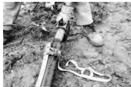
Нагреть внутреннюю трубу горячим воздухом или горячей водой, дать остеть – готово!
