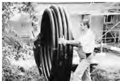
Размотать бухту до следующей фиксирующей ленты, только после этого разрезать следующую фиксирующую ленту.
