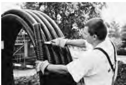
Установить бухту труб CALPEX в начале трассы и разрезать крайнюю наружную фиксирующую ленту.
